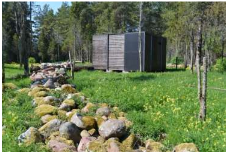
Foto 9. Kiviplokkidele tõstetud ajutine moodul-varjualune, mis likvideeritakse (foto: erakogu)
